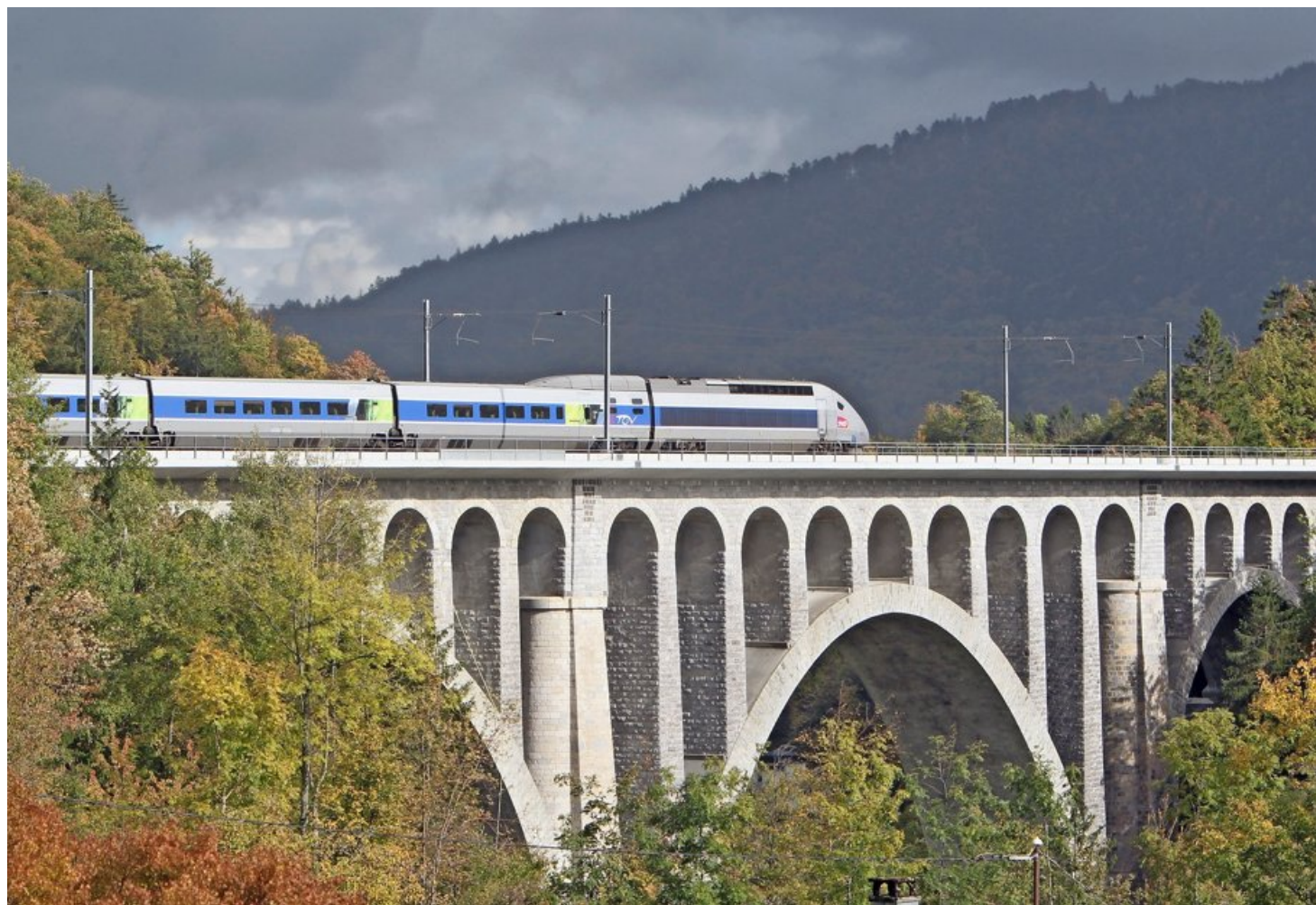
La ligne Lausanne-Paris passe par le viaduc du Day, non loin de Vallorbe, où quatre TGV s'arrêtent par jour. OLIVIER ALLENSPACH
